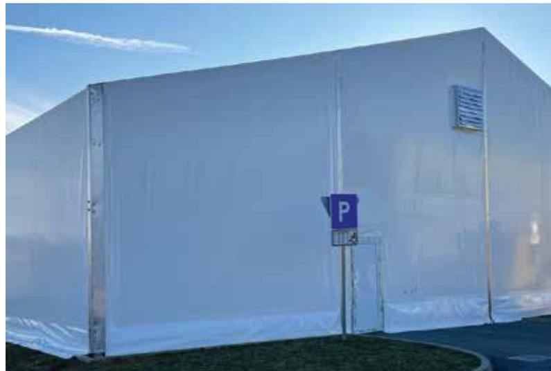
**6** / Je nach Bedarf und Zweck kann die Halle mit einer Plane, mit Paneelen oder einem Trapezblech abgedeckt werden.
