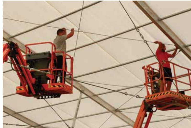
**9** / Das System aus Aluminiumprofilen zeichnet sich durch hohe Widerstandsfähigkeit sowie einfache und schnelle Montage aus, ohne Einsatz von schweren Maschinen.
