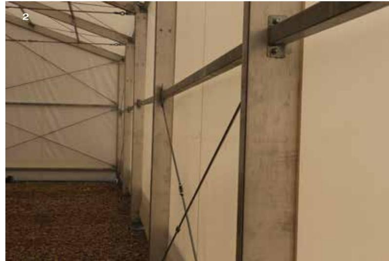
**1 /** Industriehallen bestehen aus Vierkanal-Aluminiumprofilen und verzinkten Stahlverbindungen, die eine solide und widerstandsfähige Basis des Objekts bilden.
